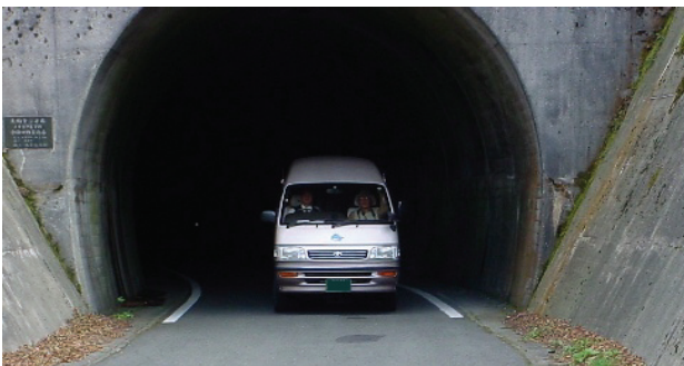
図4 現在の天狗トンネル地芳峠側坑口
